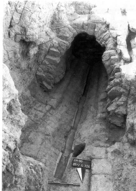
Abb. 95. Tall Šeh Hamad, Raum J mit doppeltem Ringschichtengewölbe. In der Mitte des abgeschrägten Fußbodens verläuft die Wasserrinne aus Ton.
